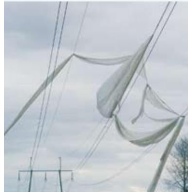
Kevätkylvöjen peiteharsojen kanssa on oltava huolellinen ja varottava, etteivät ne lennä voimajohtoihin. Johtoihin takertuneet harsot on aina turvallisuussyistä jätettävä ammattilaisten irrottaviksi, koska vähänkin kostunut tai likaantunut harso johdtaa sähköä.
