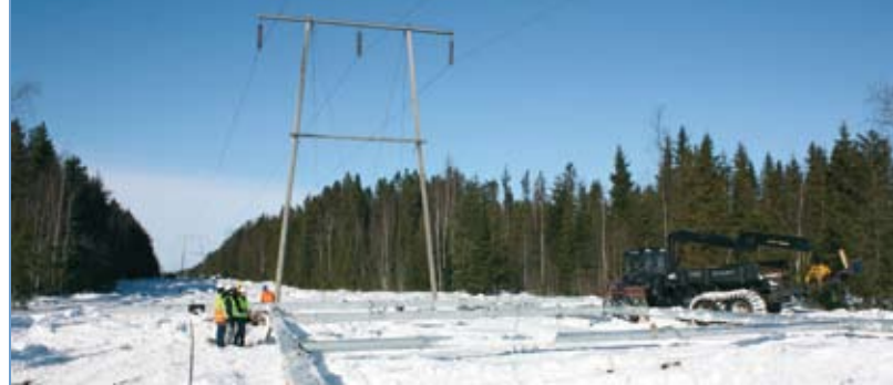
Uutta 400 + 110 kV pylvystä kasataan käytössä olevan nykyisen 110 kV voimajohtojon alla.
